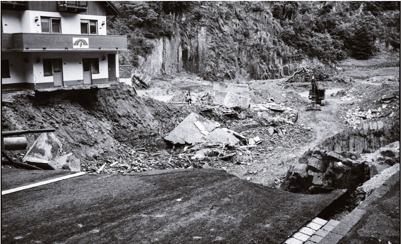
Deutschland, Altenahr, 26. August 2021, Zerstörung total: Die Autobahn 267 wird vor dem Tunnel in Altenahr komplett weggespült. Die Überreste überragen einen meter-tiefen Krater. Foto: Picture Alliance/ Fotograf: Marcel Mayer
