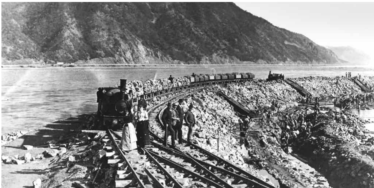
Baustelle des „Eisernen-Tor-Kanals“, der 1896 fertiggestellt wurde. Die Anlage dieses 1,7 km lange Kanals war die wichtigste Voraussetzung dafür, dass Tank- schiffe von Rumänien bis nach Regensburg verkehren konnten. Links des aufgeschütteten Damms sieht man den mit Felsen durchsetzten, problematischsten Abschnitt des „eisernen Tores“, rechts davon den ausgesprengten Kanal.
