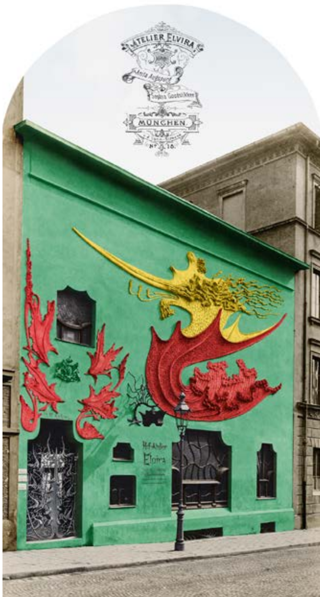
Originalfassade des Ateliers Elvira Foto: KW Neun/Augsburg
