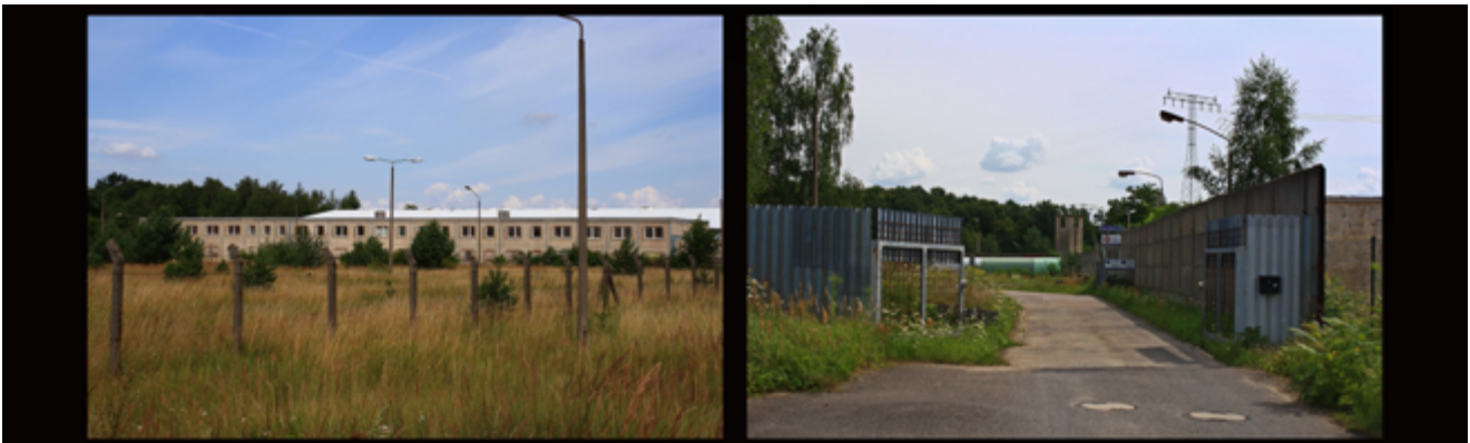
Rechts sieht man die Disziplinareinheit des ehemaligen NVA-Militärgefängnisses Schwedt und links Wachturm und Eingangsbereich. Nicht mehr vorhanden ist die Eingangsschleuse mit 3,5m hohen Stahltoeren.
