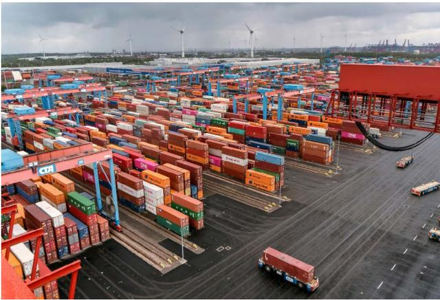
Container-Terminal Altenwerder (CTA) der Hamburger Hafen und Logistik AG (HHLA) in Hamburg am 06.05.2019. Das CTA ist eines der modernsten Containterterminals der Welt. Die meisten Abläufe sind hier automatisiert. Einzig das Entladen des Containers aus dem Frachtraum des Schiffs übernimmt ein Mensch. Alles Weitere – das Laden der Container auf Transportfahrzeuge, der Transport zum Blocklager, das Entladen sowie später das Laden des Containers auf einen Lkw – geschieht automatisiert.
