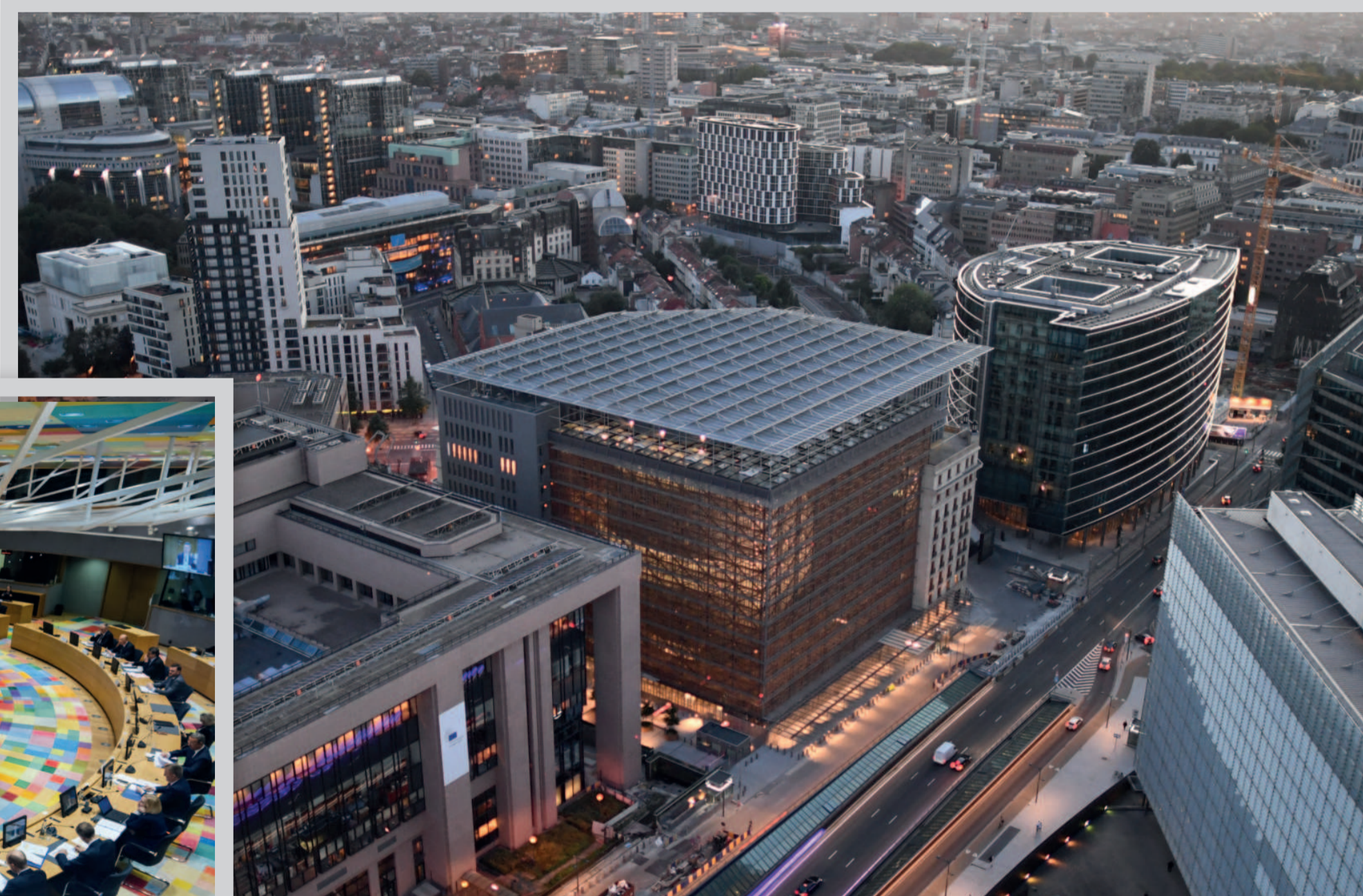
Das Europagebäude in Brüssel
