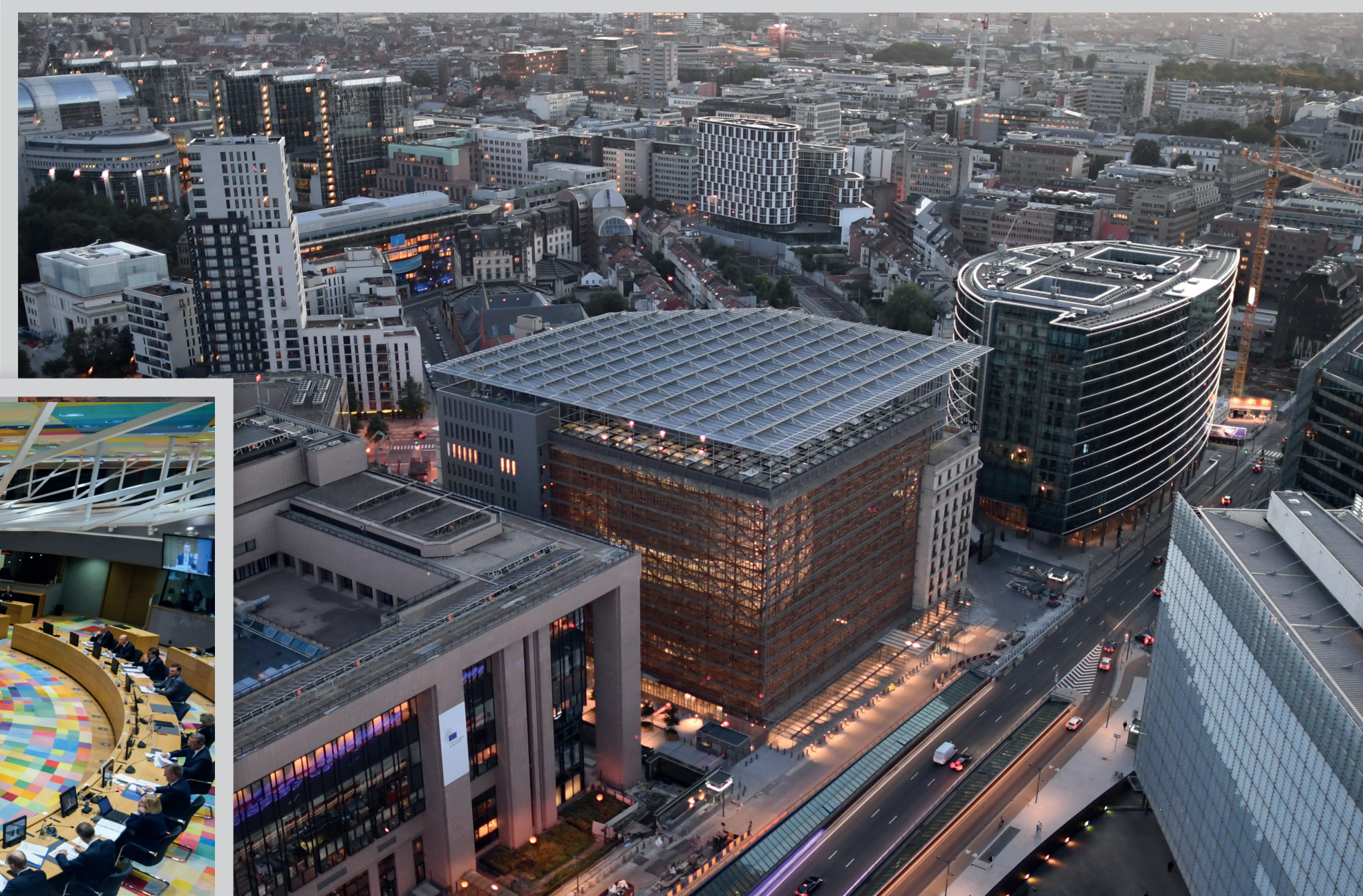
Das Europagebäude in Brüssel
