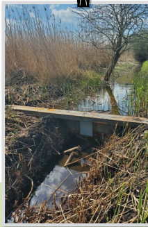
Angestauter Graben. Durch einen solchen Grabenanstau kann der Wasserstand in den angrenzenden Flächen wieder angehoben werden. Foto: © Eva Schmidt
